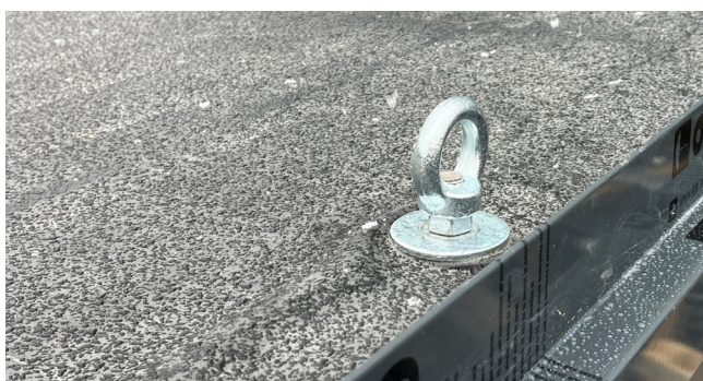
Detail Transportösen am Dach der Gartensauna LUNA
